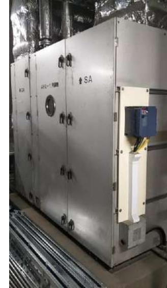
インバーター式制御式外調機
