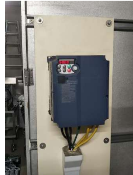
インバーター式制御式外調機
