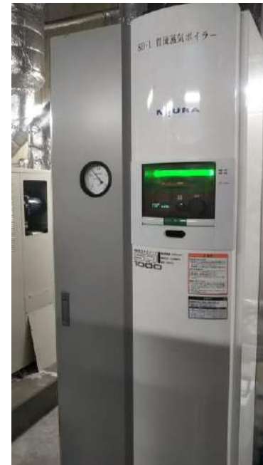
貫流蒸気ボイラー (エコノマイザー内蔵)
