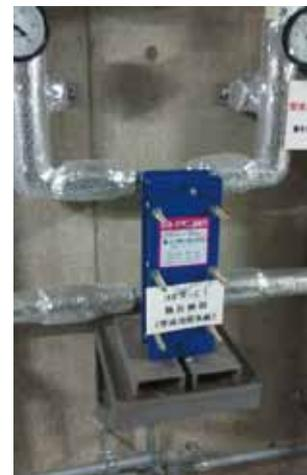
雪床冷房システムの熱交換器
